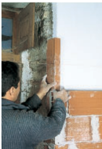
Ci-dessus, un doublage en briques plâtrières.
